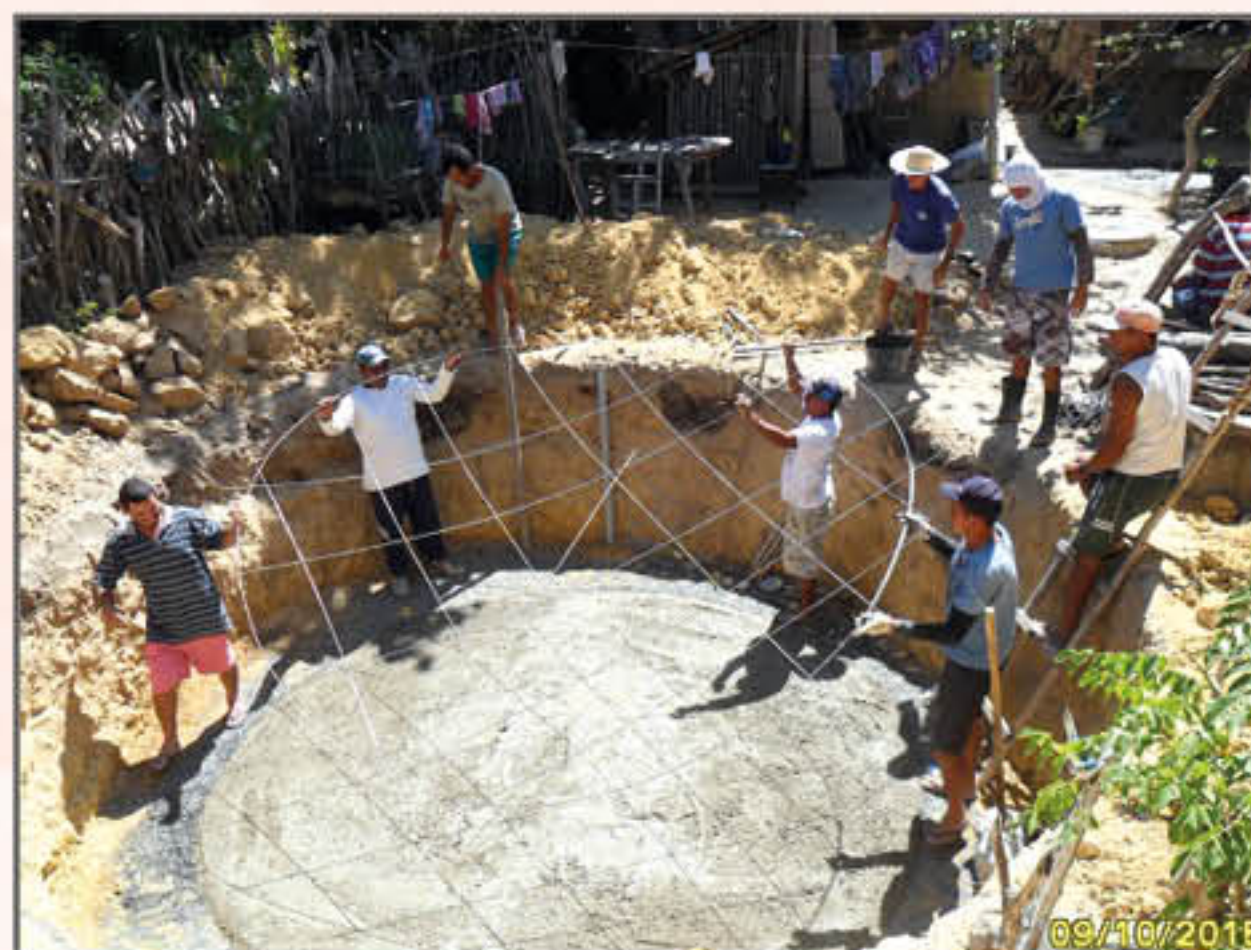
Colocando a estrutura de ferro.
