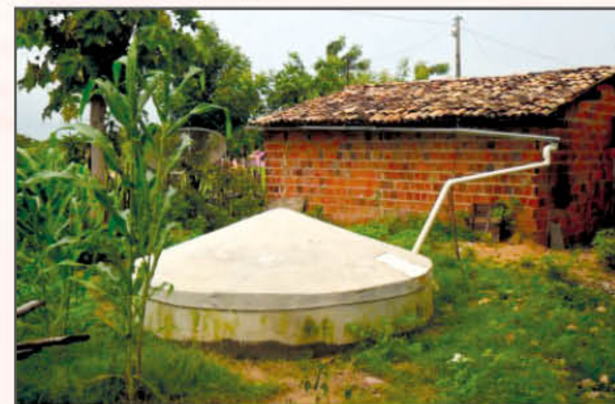
Cisterna com calha e cano condutor da água.
