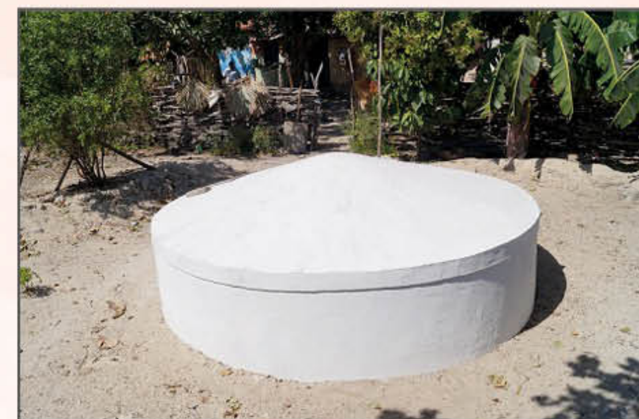
Cisterna pintada pronta.
