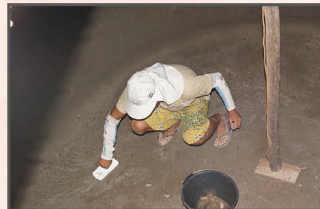
Vedando a cisterna.
