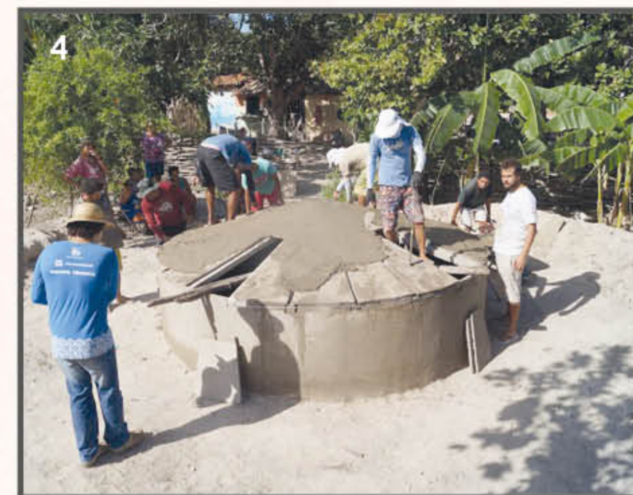
Rebocando o teto.
