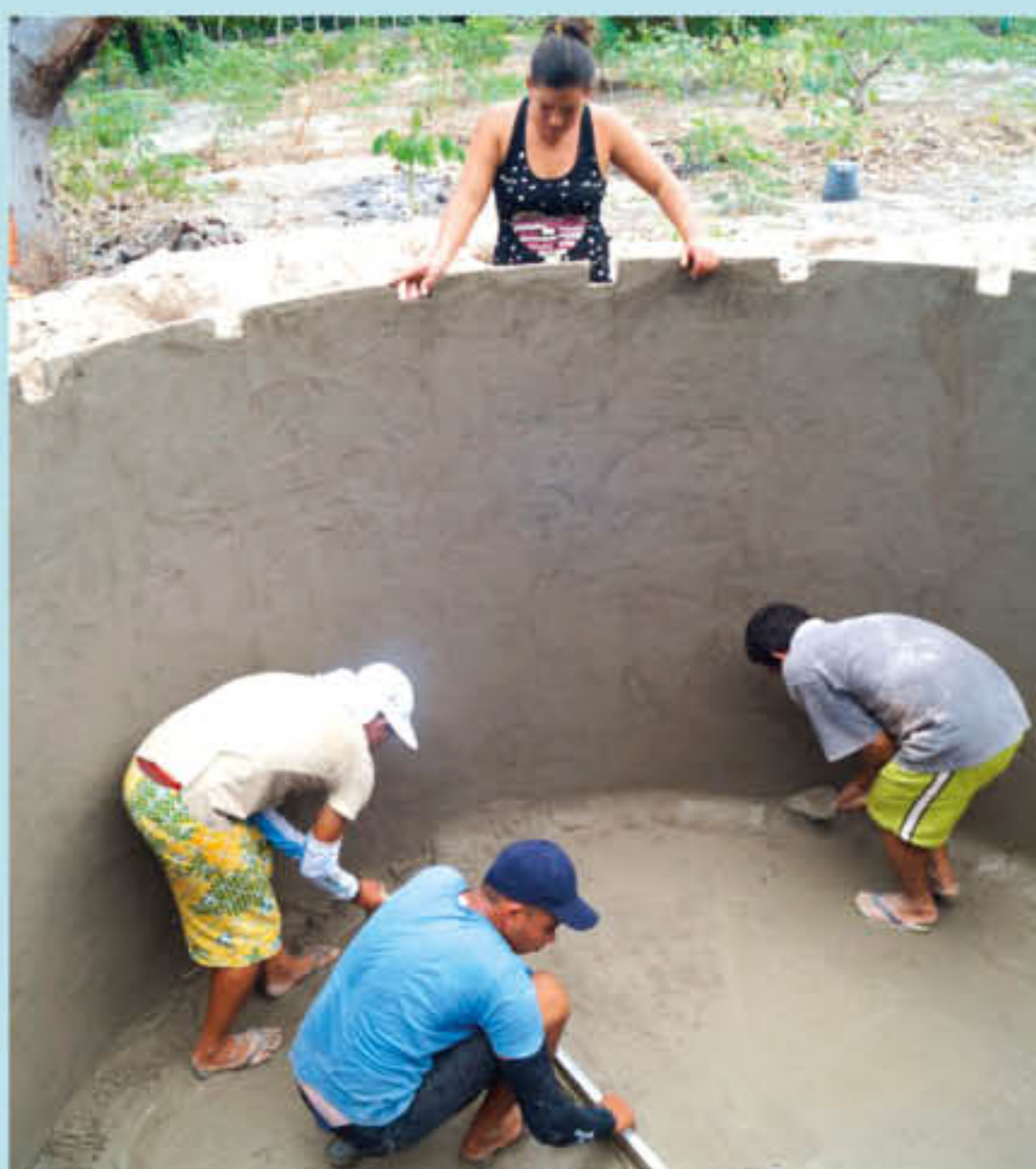
Reboco do contrapiso.
