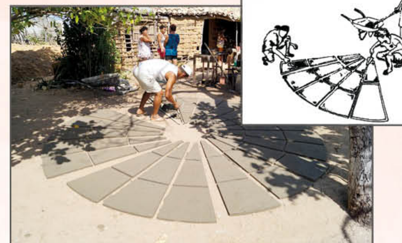
Placas da cobertura
